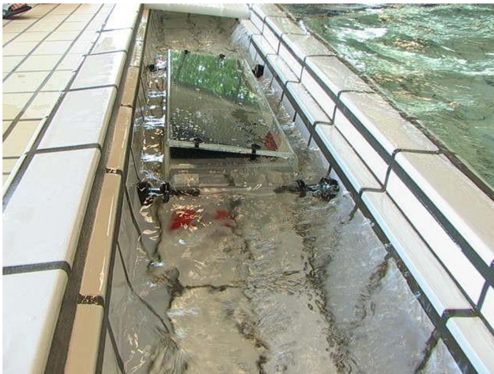
Foto 2 Overløbsrende med støjdamper.
