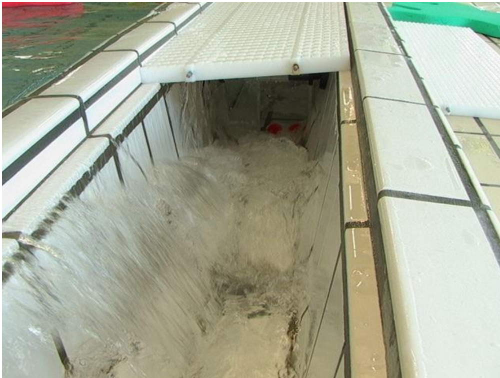
Foto 1 Overløbsrende uden støjdæmper.
